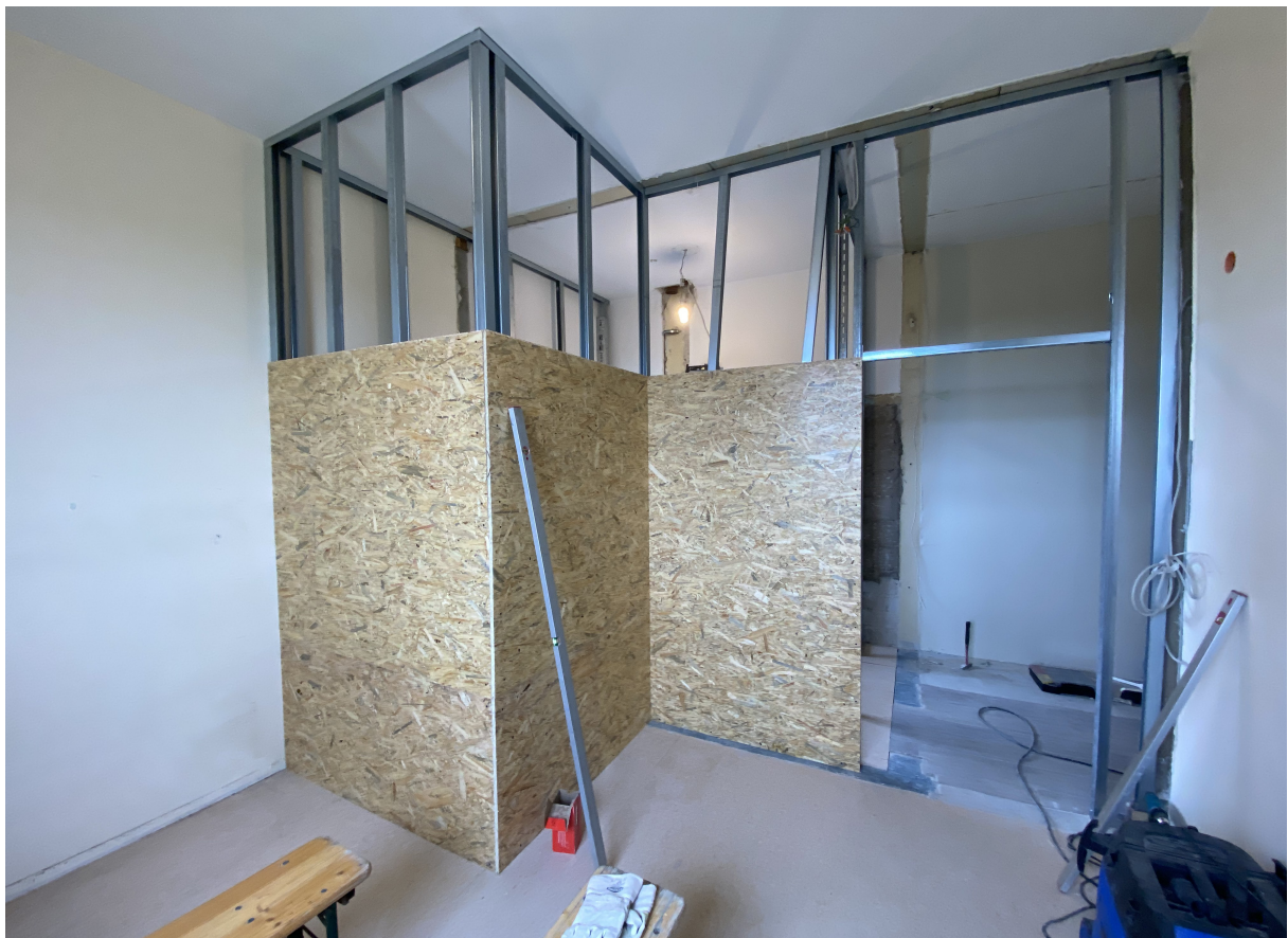
Das neue Ständerwerk Zimmer 31 und Bad
