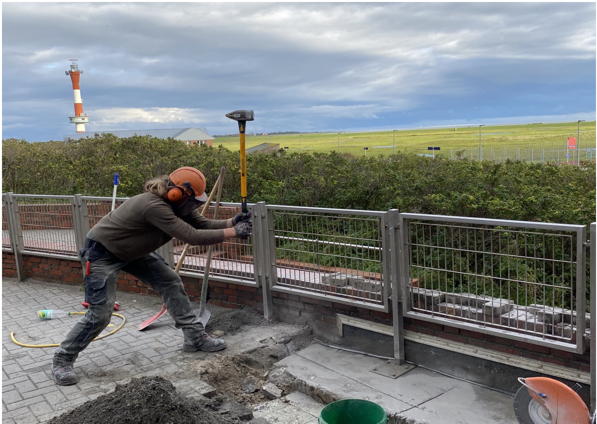
Arbeiten auf der Terrasse
